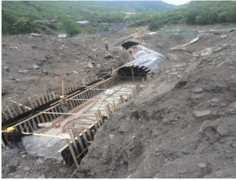
图9 西铭矿磺厂沟滑坡段河道治理（涵洞）图
