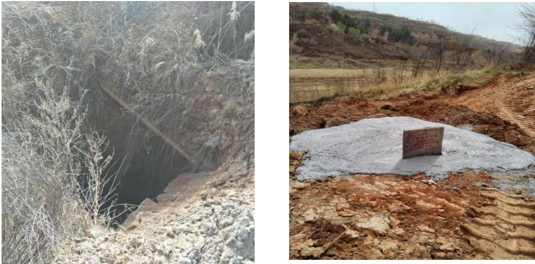
图 18 柳湾矿井沟副井封堵图
