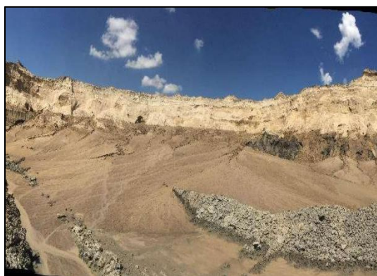
图5 超前降水前第四系细砂含水层
