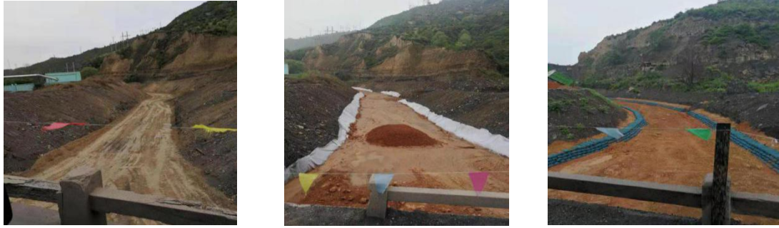
图 6 西曲矿矸石沟河道（土工布、强夯加粘土铺底）图
