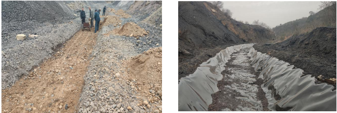
图 7 晋牛煤矿西坡河道（土工布、黄土夯实铺底）图
