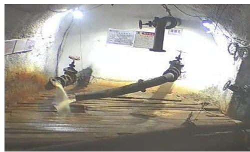
图 21 马兰矿北一暗斜防水闸墙
