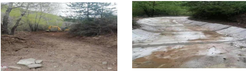
图5 西铭矿冀家沟河道采用水泥毯治理图
