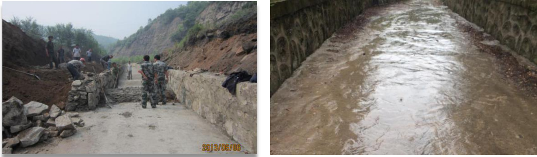
图4 西铭矿磺厂沟河道治理前后对比图（片石砌坝混凝土铺底）图
