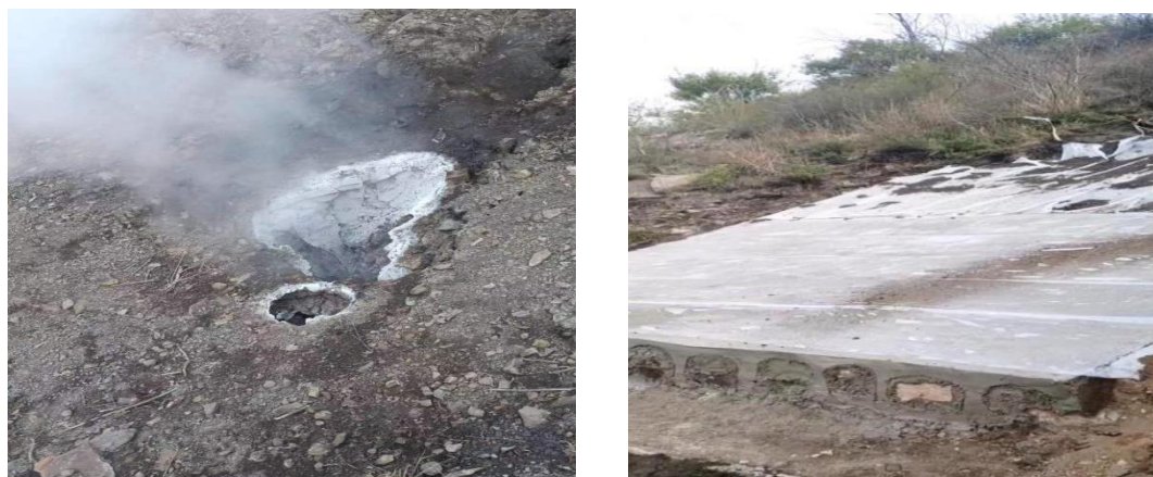
图 17 杜儿坪矿南峪沟地表塌陷坑治理前后对比图
