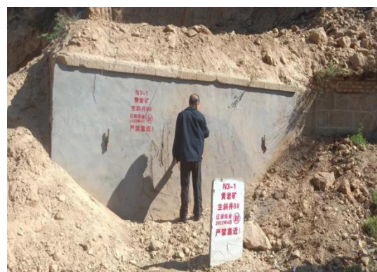
图 14 辽源煤业黄岩矿主斜井图
