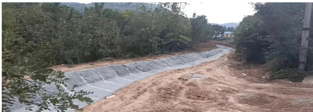
图 3 万杰煤业 2-105 工作面地表明渠铺设水泥毯治理图
