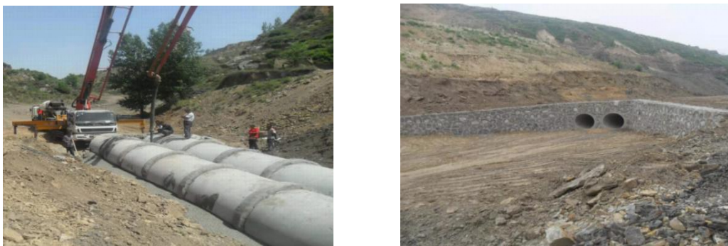
图 8 西曲矿矸石沟滑坡段治理（涵管）图
