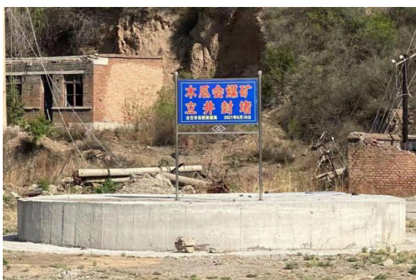
图 13 屯兰矿木瓜会煤矿主立井封堵图
