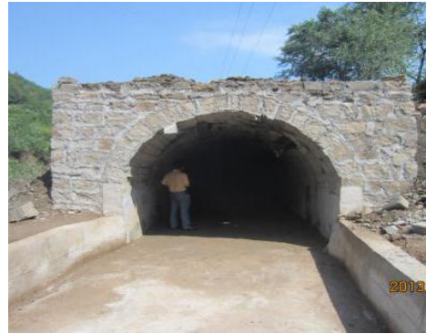
图9 西铭矿磺厂沟滑坡段河道治理（涵洞）图
