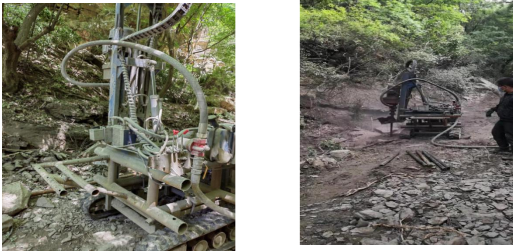
图 12 生辉煤业余家岭沟河床注浆治理图
